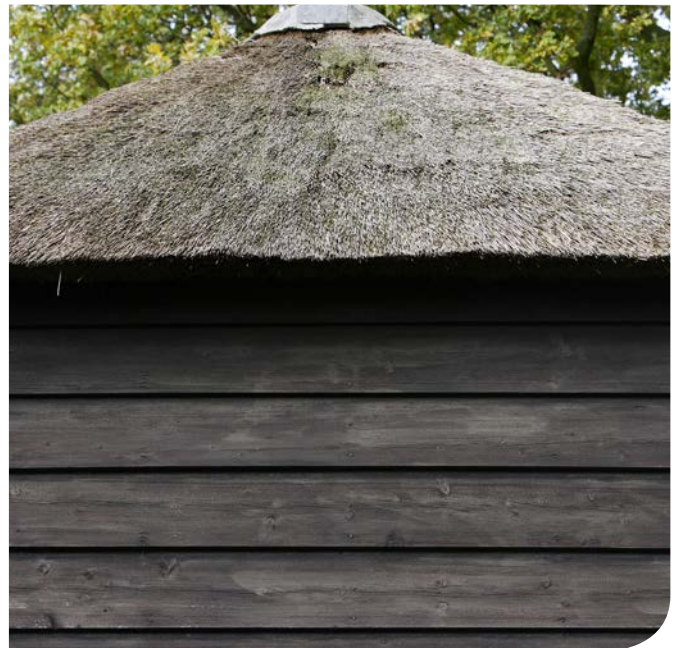
Getrapte weeg of gepotdekselde wand
