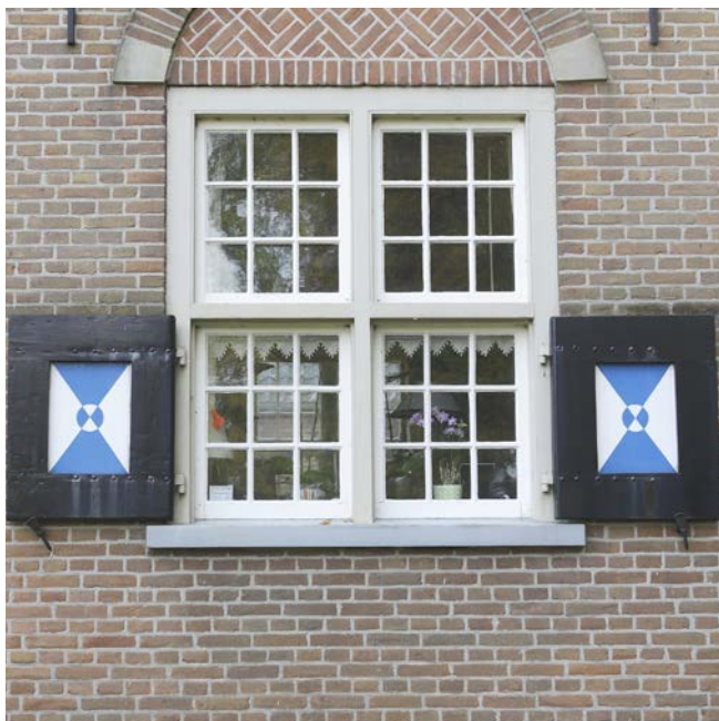
Kruisvenster in portierswoning van Zuylestein in Leersum
