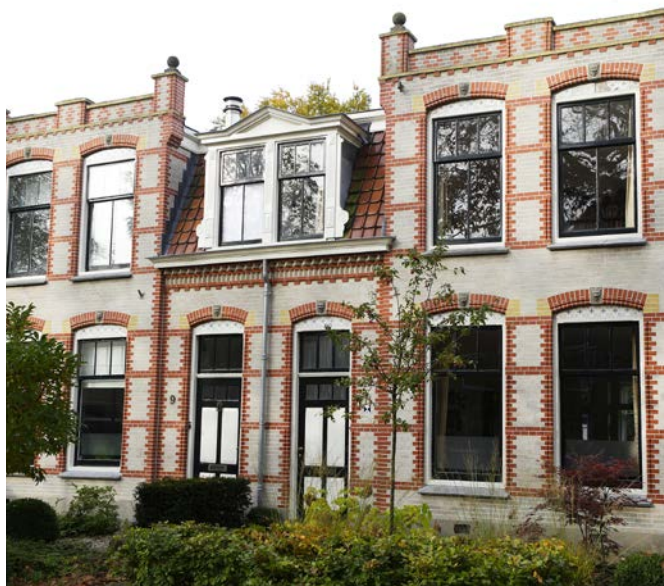
Woonhuizen met siermetselwerk aan de IJskelderlaan in Doorn
