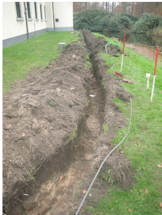
Op de voorgrond in de smalle sleuf zijn de fundamenteën zichtbaar van de noordwestelijke hoektoren. Op de achtergrond is de ronding van de nog bestaande hoektoren te zien.
