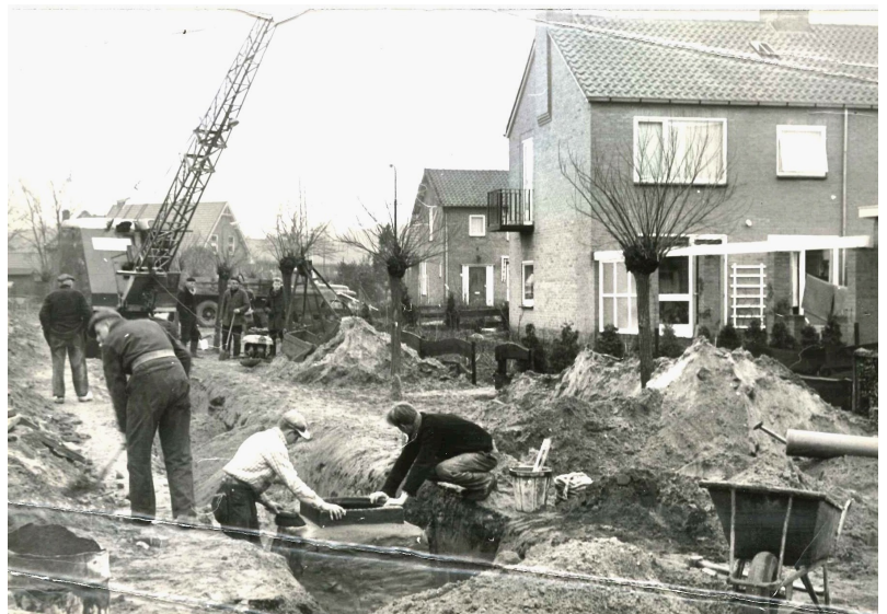
In de jaren 60 van de twintigste eeuw wordt de riolering aangelegd in de Bentincklaan. Deze foto toont de werkzaamheden op de hoek van de Kon. Julianaweg en de Bentincklaan. De urnen zijn gevonden in het gedeelte dat achter de fotograaf ligt. (foto: Archief ZuidoostUtrecht)
