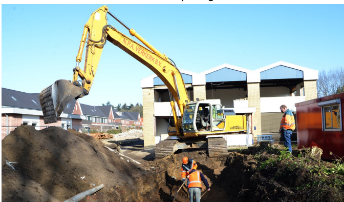
Na het booronderzoek volgde een proefsleuvenonderzoek. Op de achtergrond is het bedrijfsgebouw van Uitgeverij Stam B.V. nog zichtbaar. Foto: A. Luksen-IJtsma
